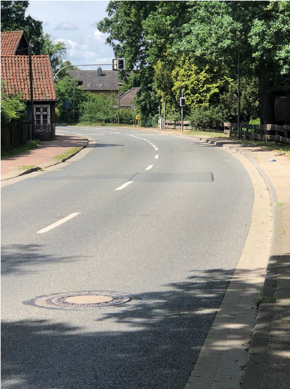
2. Richtung Mellendorf – Standort: Höhe Celler Str. 20
